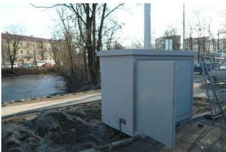
**В выносном боксе находится вводной электрический щит и все оборудование системы автоматизации ААЗС.**
