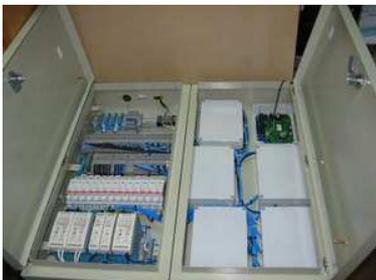
**Коммуникационный щит системы телеметрии в сборе с исполнительными устройствами.
